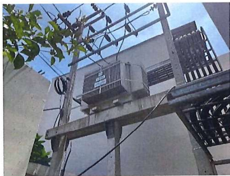
รูปที่ 28 หม้อแปลงไฟฟ้าของโครงการ
