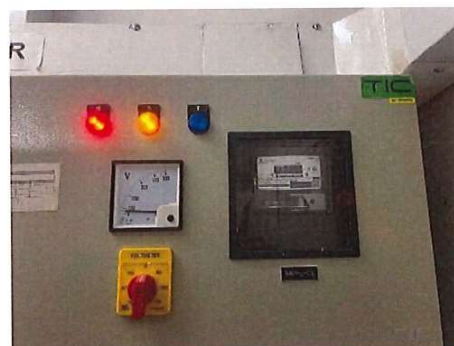
รูปที่ 15 ระบบมิเตอร์ไฟฟ้าสำหรับระบบบำบัดน้ำเสีย
