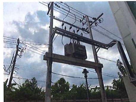
รูปที่ 28 หม้อแปลงไฟฟ้าของโครงการ
