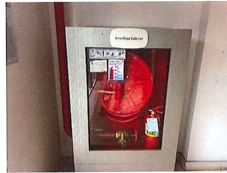
รูปที่ 37 ตู้เก็บสายฉีดน้ำดับเพลิงพร้อมอุปกรณ์ (Fire Hose Cabinet: FHC)
